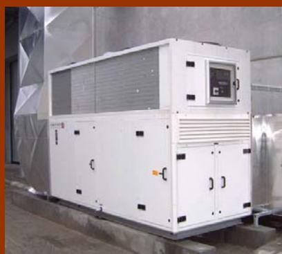
Die Konstruktion ist, bis auf einen massiven Grundrahmen, rahmenlos, daß heißt, die Sandwichplatten werden miteinander verschraubt, die Stösse gedichtet, isoliert und mit einem Profil abgedeckt. Ebenso werden die Ecken und Kanten ausgebildet, zusätzlich mit Stahlwinkeln verstärkt und mit abgerundeten Abdeckprofilen abgedeckt.
